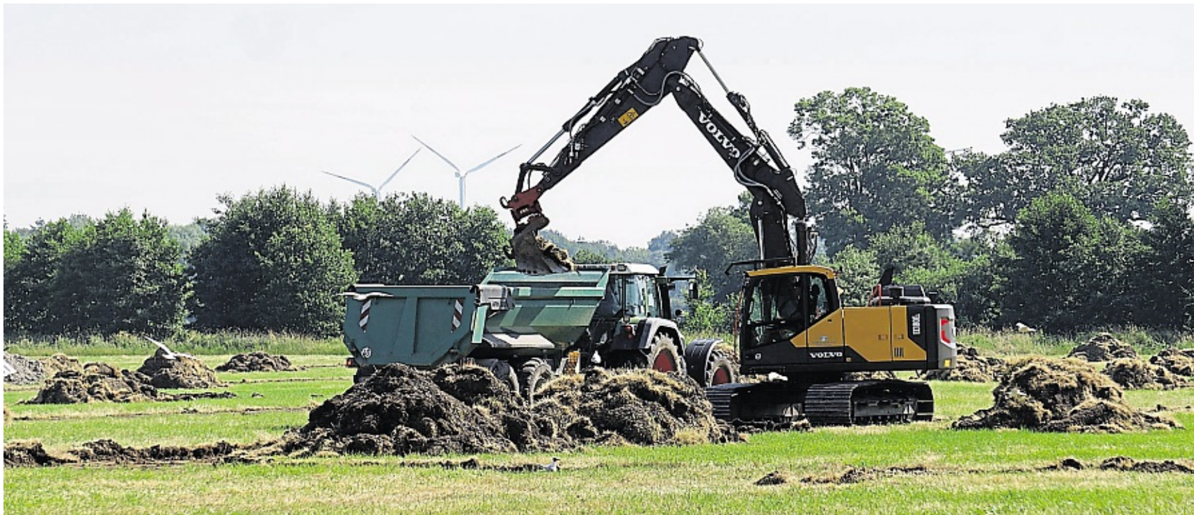
In einem ersten Schritt wird von den Flächen, die bei Festivals an der Ippenburg zum Parken dienten, der Splitt abgefahren.
